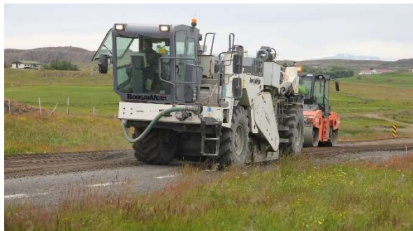
Mynd 12: Þurrfræsing er fyrsta skref sementsfestunnar
