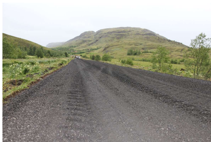
Mynd 20: Skálholtsvegur eftir að núverandi vegur var þurrfræstur.
