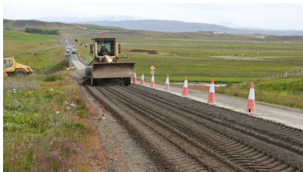
Mynd 14: Heflun efnisins um leið og blöndun þess er lokið
